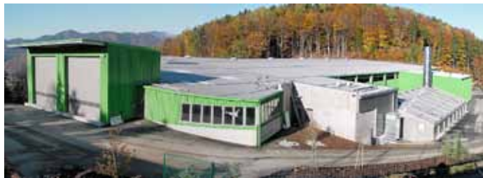
Frohnleiten, obrat za mehaniko in biološko predelavo odpadkov
